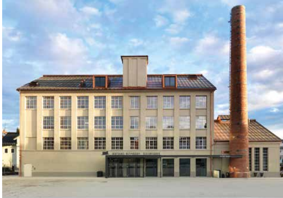
Zur Erweiterung des Eingangsbereiches ist ein Windfang vor das Gebäude gesetzt worden. Foto: Richie Müller, DHML
