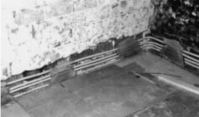
Mauertrockenlegung mittels thermischer Horizontalsperre
