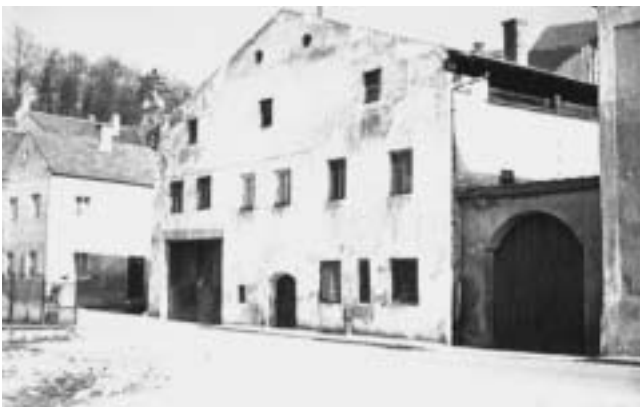
Das Weißgerberhaus, Bauzustand 1956
