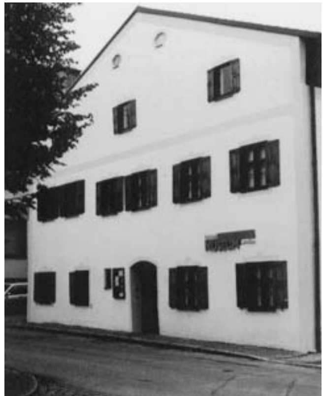
Das Heimatmuseum nach abgeschlossener Sanierung
