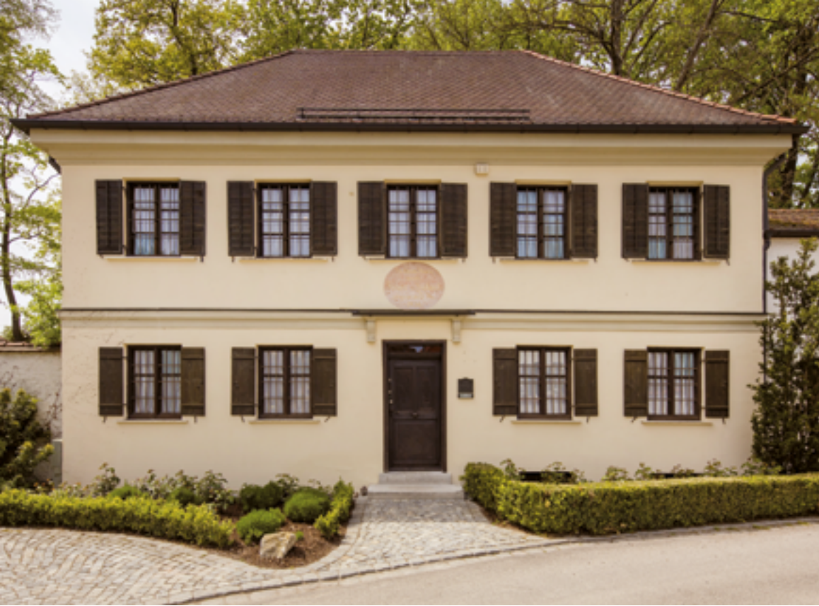
Lenbachmuseum Schrobenhausen, Außenansicht Foto: Landesstelle
