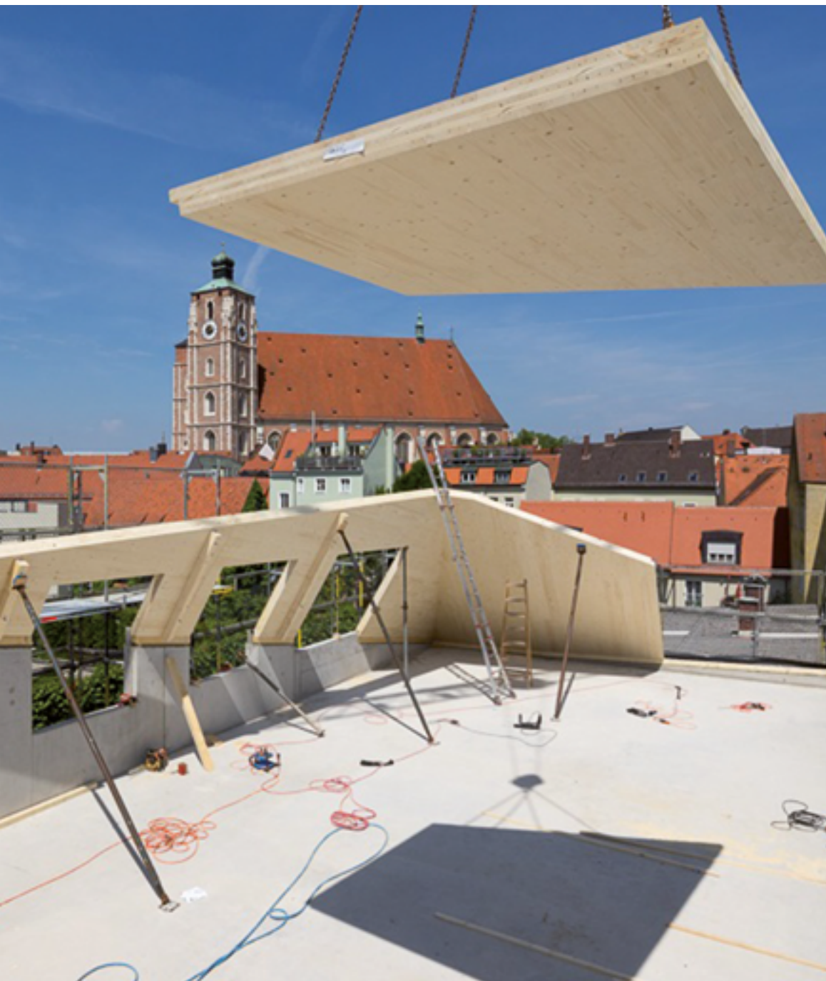
Erweiterungsbau des Medizinhistorischen Museums Ingolstadt: Das Dach wird zusammengefügt, 2015. Foto: Marcus Ebener, Berlin
