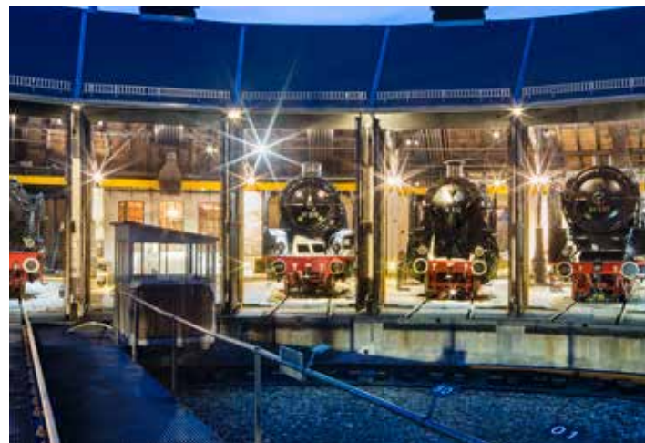
Ringlokschuppen des Bahnbetriebswerks mit Segmentdreh-scheibe.
